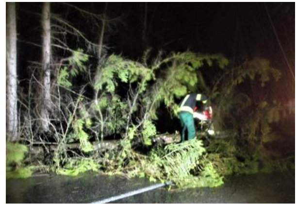
Entfernung eines umgestürzten Baumes von der B144 zwischen Roitham und Traunfall
